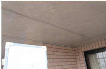
上裏(塗料施工後)
