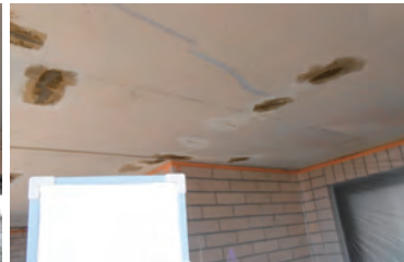
上裏(塗料施工前)
